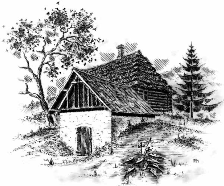
Przykład wiejskiej piwnicy zagłębionej częściowo w ziemi
